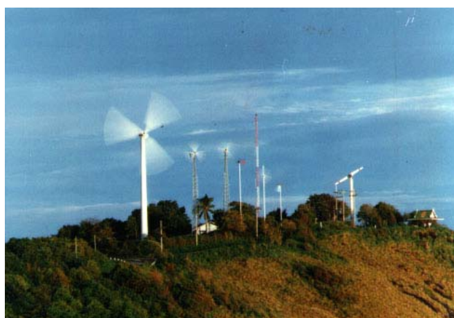
ภาพที่ 6.10 สถานีผลิตไฟฟ้าจากพลังงานลมร่วมกับระบบเซลล์แสงอาทิตย์ของการไฟฟ้าฝ่ายผลิต ที่แหลมพรหมเทพ จังหวัดภูเก็ต ที่มา (Siripuekpong et al. 2002 : 58)
