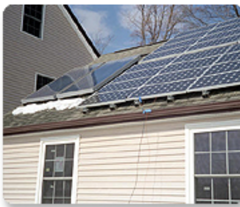
ติดตั้งแผงเซลล์สุริยะบนหลังคาบ้าน
