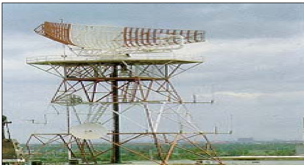
รูปที่ 10 รูปแสดงสายอากาศของเครื่องเรดาร์[16]
